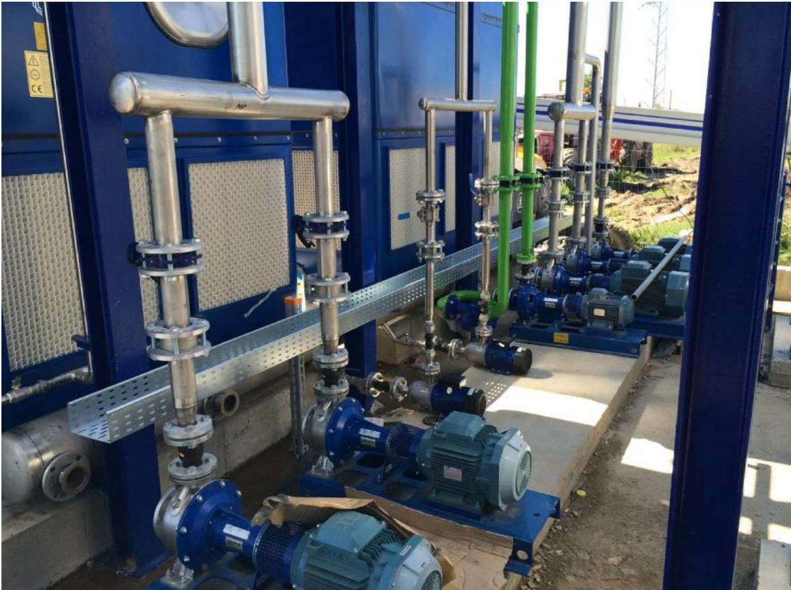
*Bombas e intercambiadores del sistema de refrigeración de la planta de generación de electricidad*
