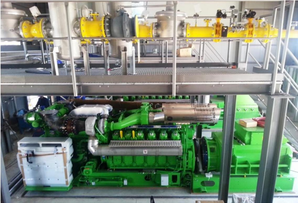
*Vista ampliada de los 3 motogeneradores GE Jenbacher y rampas de syngas en fase de montaje*
