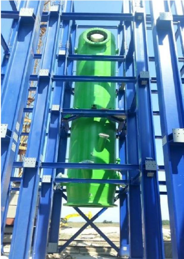
*Vista detallada de las tolvas de recogida de cenizas de la gasificación.*
